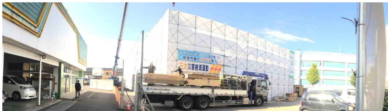
「シャロームめぐみの」建設工事現場 10月14日撮影
